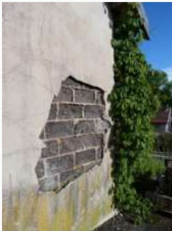
Mur en blocs de mâchefer / enduit ciment.
