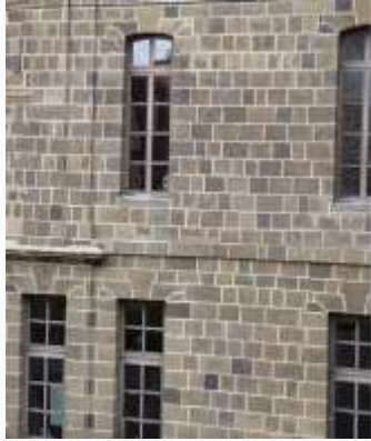
Mur de pierres appareillées.
