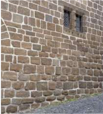
Mur rejointoyé au mortier de ciment.
