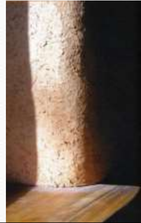
Application d'un enduit « chanvre-chaux »
