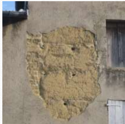
Mur pisé, enduit ciment.
