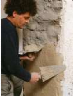
Application d'un enduit « chanvre-chaux »
